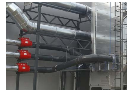
Установка В-FLAP I на впускном трубопроводе.
